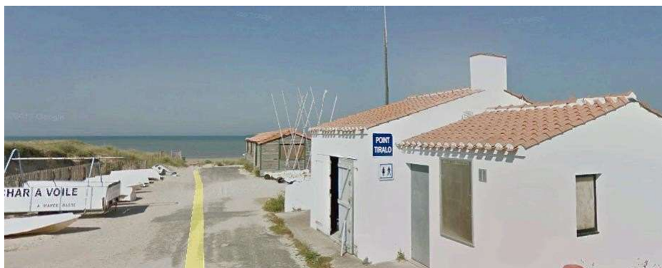
Constructions existantes situées Avenue de l'Océan (NB : constructions situées dans la bande des 100 mètres).
