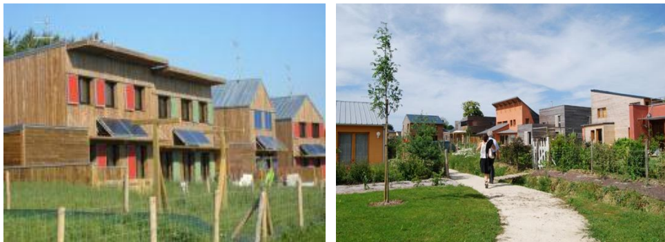
Lotissement communal Hédé-Bazougers (35)
