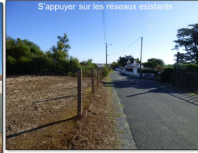
S'appuyer sur les réseaux existants
