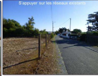
S'appuyer sur les réseaux existants
