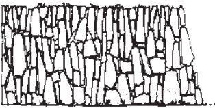
Mur en pierres debout
