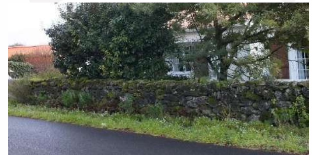
Muret (rue de l'Estacade)
